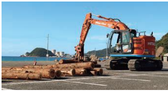
道路の啓開訓練(24日)
