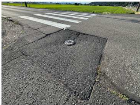
つぎはぎ舗装による凹凸の解消
