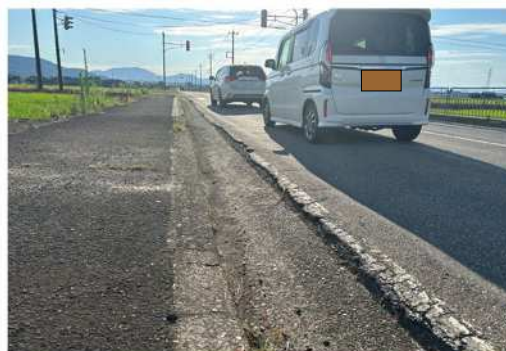
路肩部舗装の欠損解消
