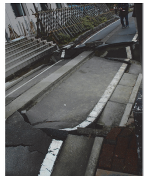
左上：建物の倒壊 左下：延焼火災の焼け跡 右3枚：液状化による下水道管や道路の被害
