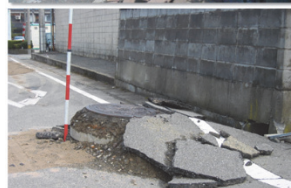
左上：建物の倒壊 左下：延焼火災の焼け跡 右3枚：液状化による下水道管や道路の被害
