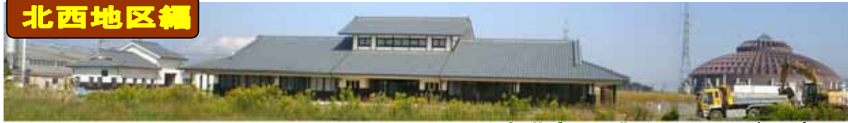
水循環センター
