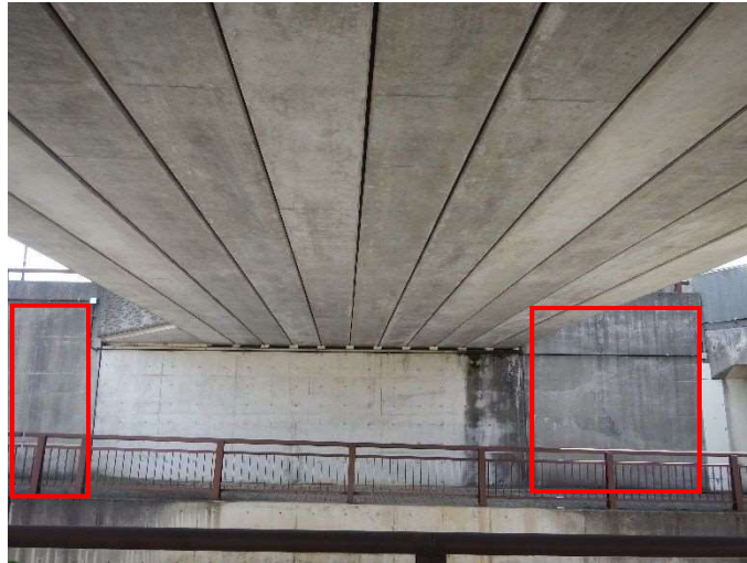
写真1 新技術を適用するモニタリング壁面
