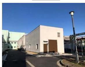
機械濃縮施設
