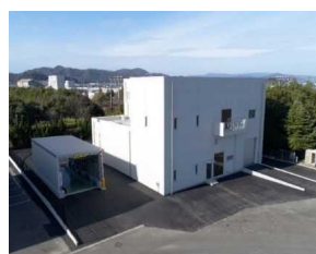
汚泥前処理施設
