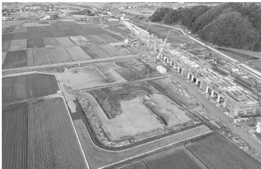
建設工事が進む南越駅(仮称)周辺
