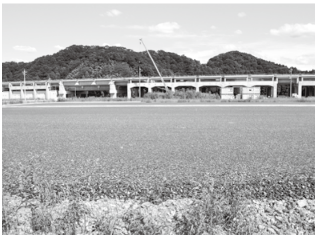
南越駅(仮称)予定地と岩内山
