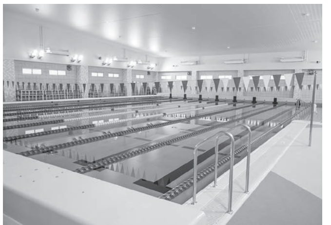
武生中央公園温水プール
