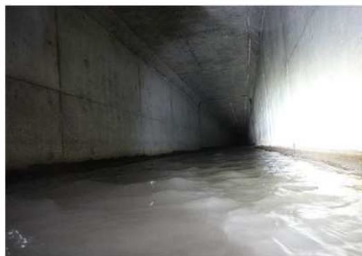
▲管路内の様子
