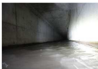
▲管路内の様子
