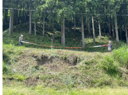
(市営林道事業 白山地区)
