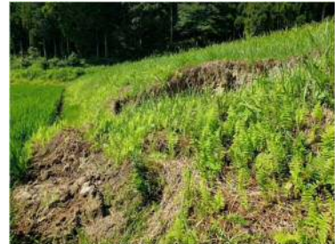
(農業施設災害復旧事業 白山地区)
