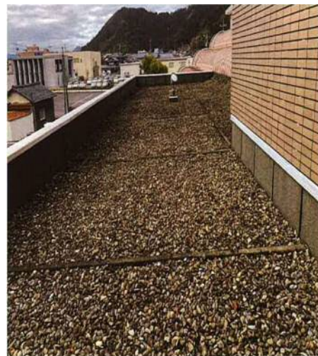
(屋上の防水工事)
