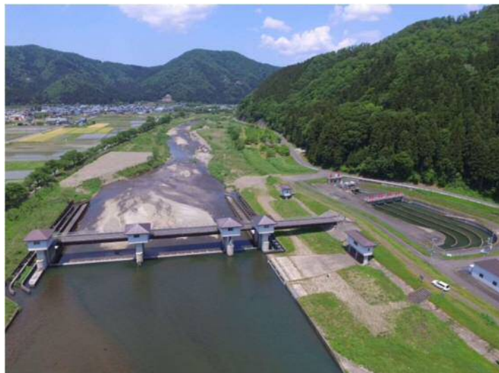
(八乙女頭首工)
