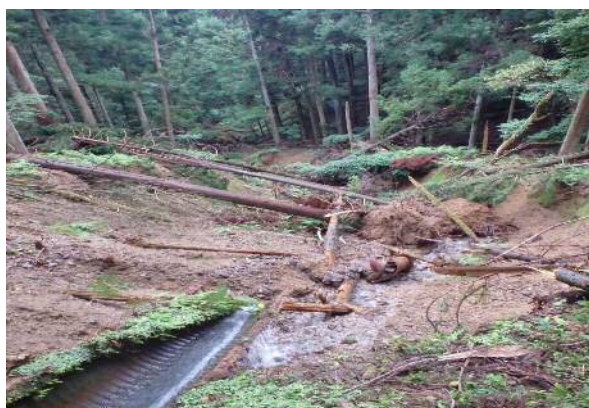
(被災した林道沿いの水路の様子)
