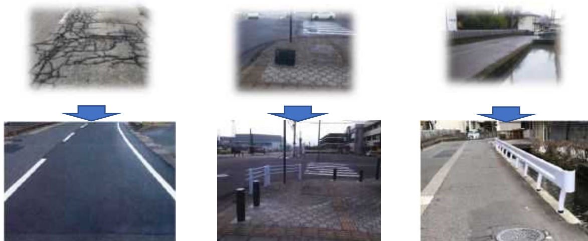
傷んだ舗装面の改修
