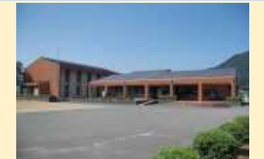
服間公民館(耐震改修設計等)
