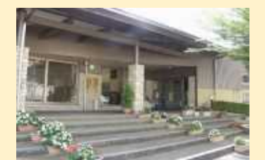
岡本公民館(空調設備更新)
