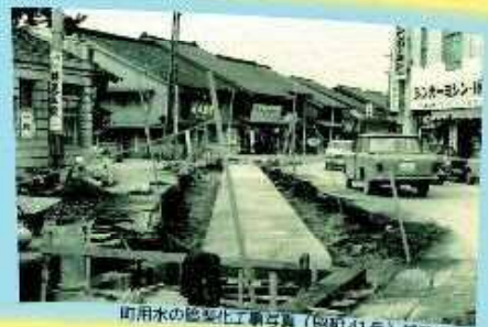
町用水の暗渠化工事写真 (昭和41年) 越前市蔵
